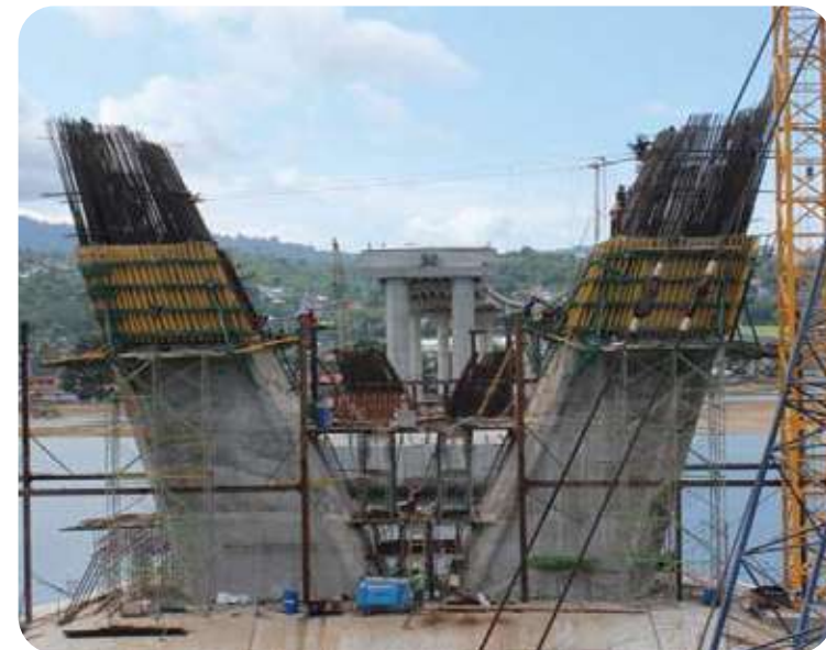
Proyek Jembatan Merah Putih Ambon, Indonesia.
