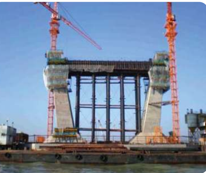
Proyek Jembatan Suramadu Surabaya, Indonesia.
