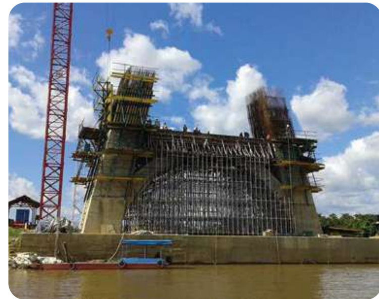
Proyek Jembatan Aji Tulus Jejangkat Kalimantan, Indonesia.
